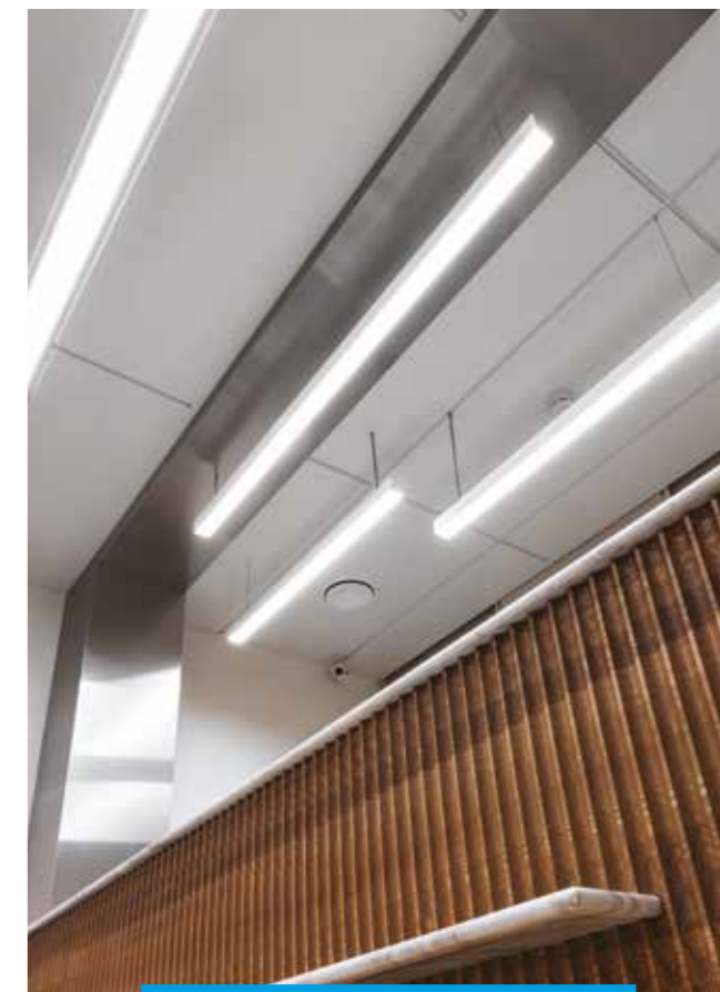
Металлическое потолочное решение LAY-IN Armstrong MicroLook 8 1200 × 600, 1200 × 300
