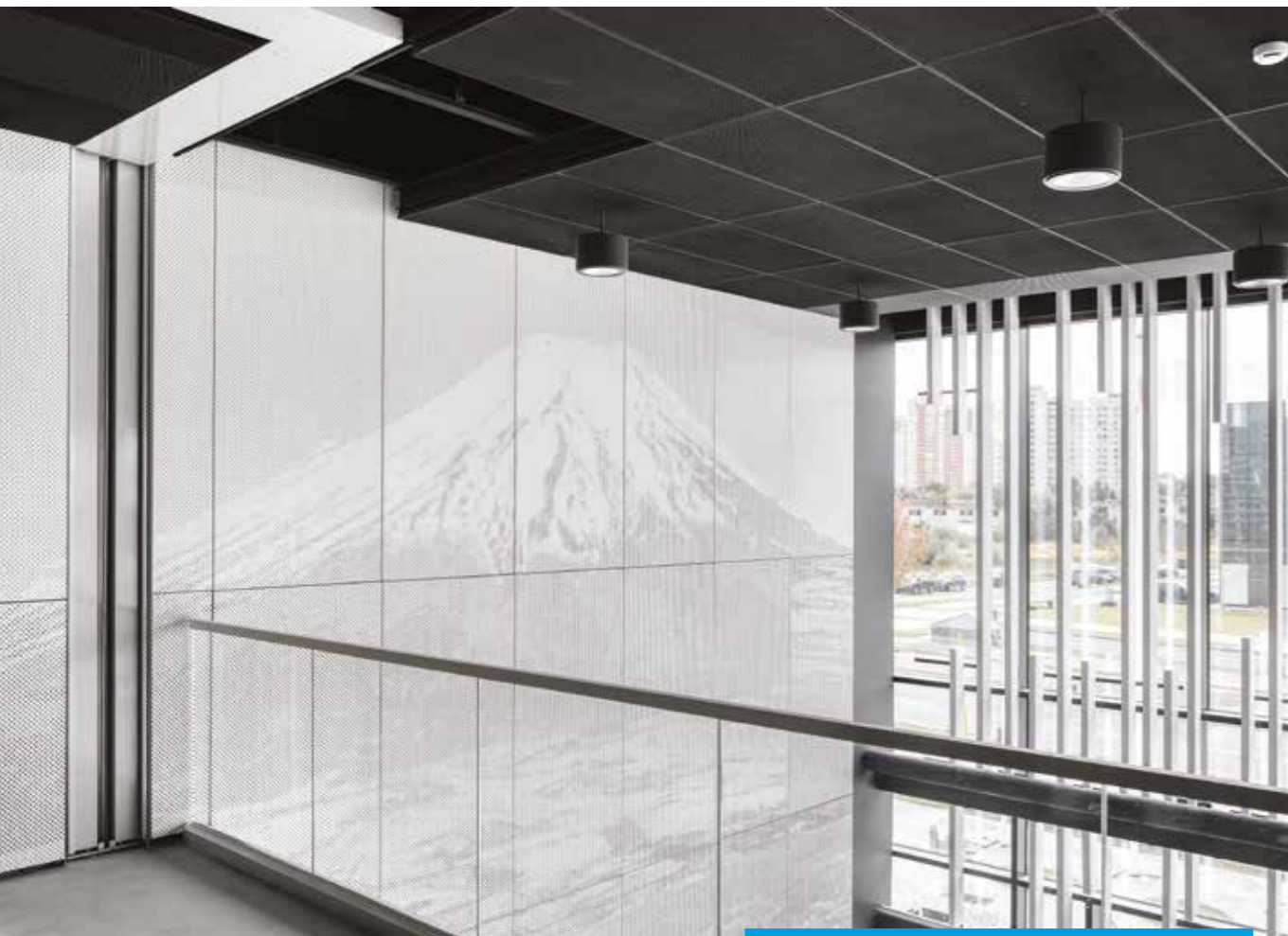
Металлическое стеновое решение Armstrong W-H 1100 с индивидуальной перфорацией (9 видов) и акустическим флисом
