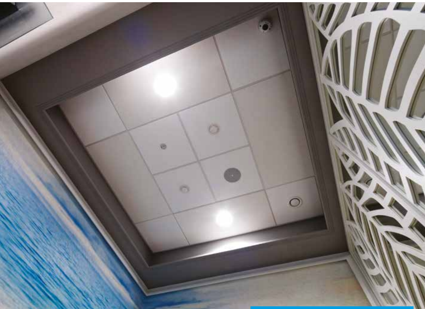
Акустические потолочные панели Armstrong Bioguard с кромкой Tegular 15 1200 × 600, 600 × 600
