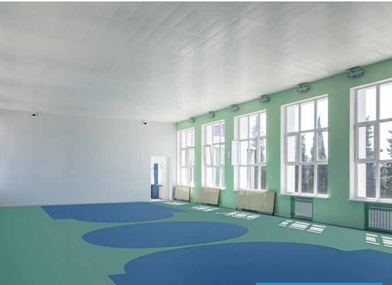
Металлическое потолочное решение CLIP-IN Armstrong V-Clip 1200 x 300 с перфорацией Rd 1522 и акустическим флисом
