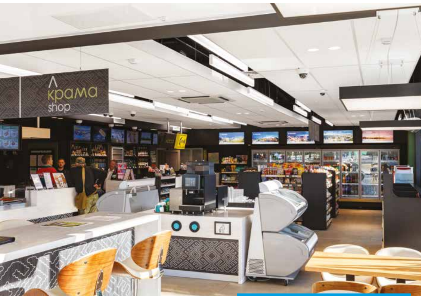
Дизайнерские потолки-фрагменты Armstrong Axiom с заполнением акустическими панелями из минерального волокна с кромкой Board, 1800 × 600
